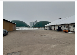
Hofflächen sind frei von Schnee- und Eisglätte zu halten. Das Streusalz darf dabei nicht fehlen.
